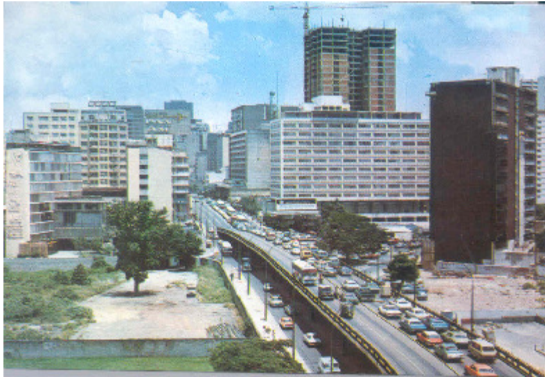
Fig. 5 Avenida Andrés Bello.
